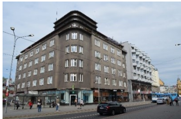
Obr.31: Budova v průměrném stavu
