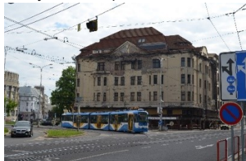
Obr.30: Budova ve špatném stavu
